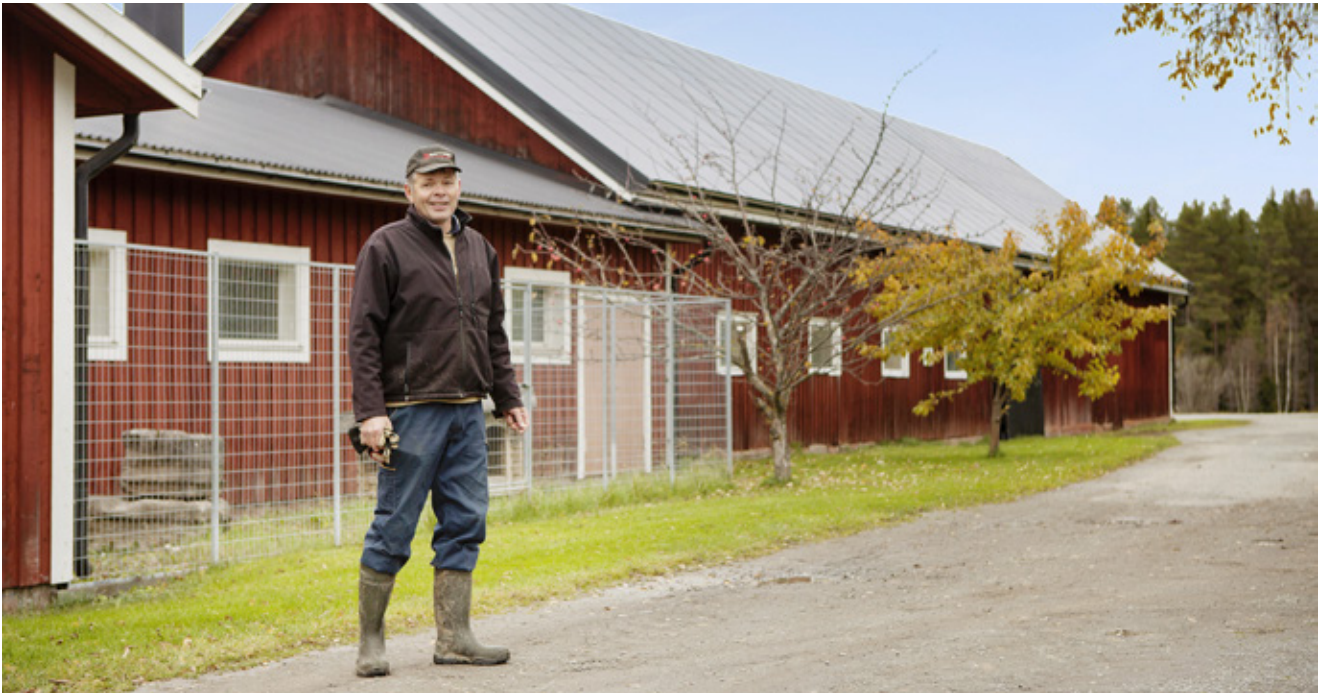
Bleka Gård har satsat både på solel och solvärme. Vid nyår 2017 togs den tredje solenergianläggningen i drift. Gården har nu en solvärmeanläggningen som genererar cirka 9 000 kWh per år. Solcellsanläggningen på ladugården ger 24 000 kWh och solpanelerna på maskinhallen 14 000 kWh. Foto: Diakrit
