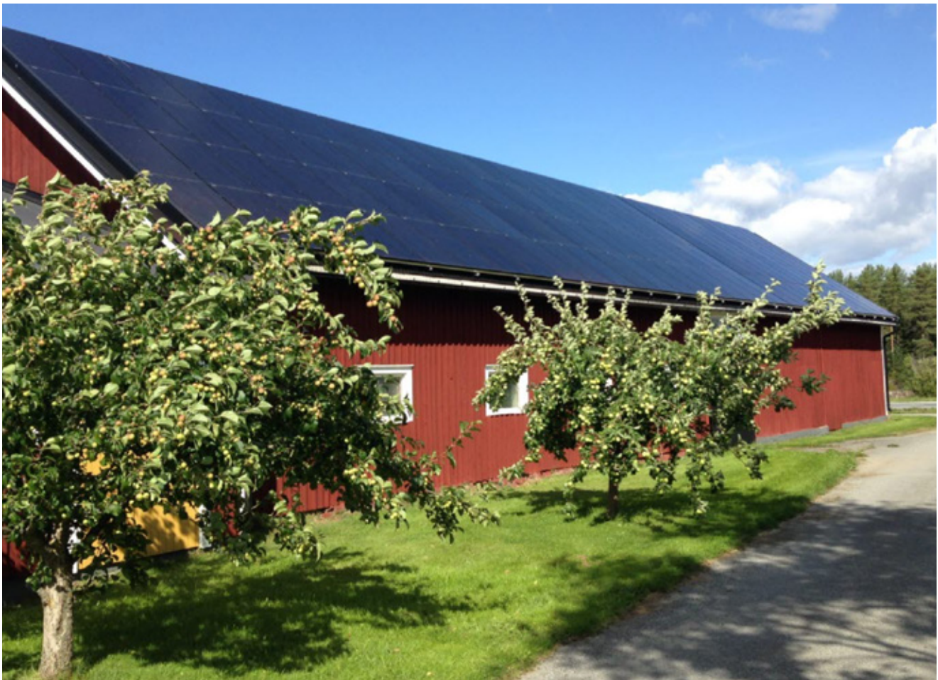
Heltäckande solpaneler på ett ladugårdstak. Foto: LRF
