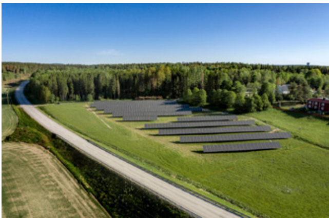
Solparken Solhagen i Torphyttan, byggd 2020 i en beteshage. Anläggningen är på 450 kW och beräknas producera 450 000 kWh per år. Foto: Linde Energi – Projekt Solhagen i Torphyttan
