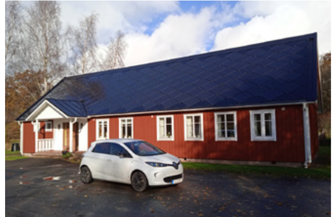
Tak täckt med solpaneler som är designade som en typ av shingelplattor, dessa fungerar även som taktäckningsmaterial. Foto: Lars Redegård
