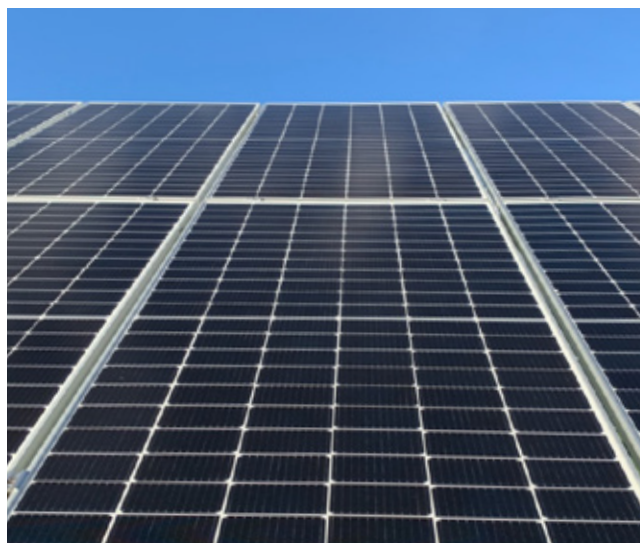
Bilden visar en monokristallin halvcellspanel. Genom att halvera solcellen skapas en högre effekt. Panelerna kan också göras större, detta sammantaget ökar solpanelens effektavgivning och därmed el-produktionen från varje enhet. Foto: Lars Andrén
