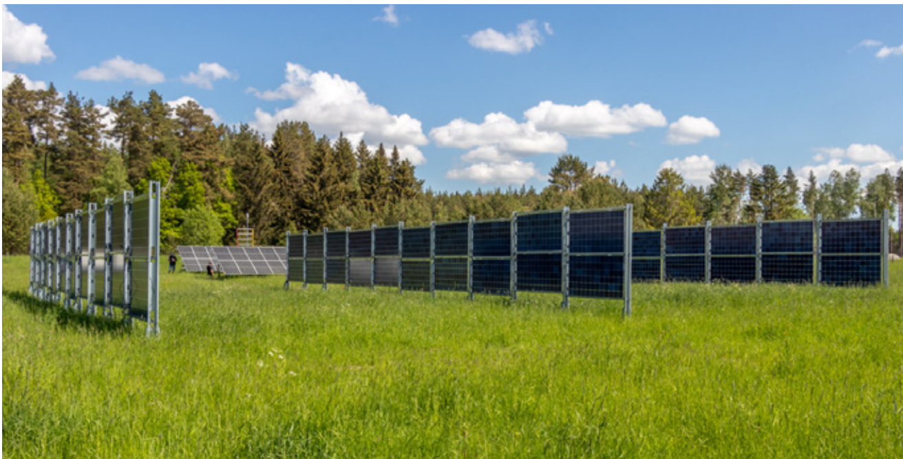
Vertikalt monterade dubbelsidiga paneler vid Kärro Prästgård i Västerås. Vertikalt ställda paneler tar lite mark i anspråk. Den här typen av projekt, där jordbruksmarken fortsätter att brukas tillsammans med solpanelerna, kallas för Agrioltaics. Foto/källa: Bengt Stridh, Mälardalens Universitet
